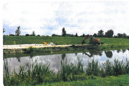
Modernizacja oczyszczalni ścieków
