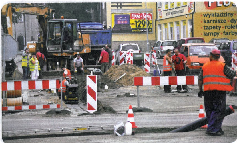
Budowa kanalizacji sanitarnej – ul. Wojska Polskiego
