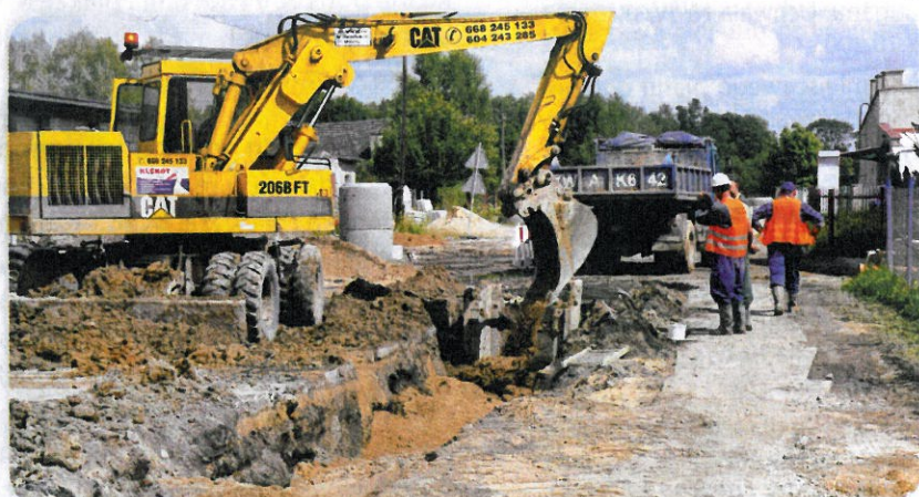
Budowa kanalizacji – ul. Połczyńska
