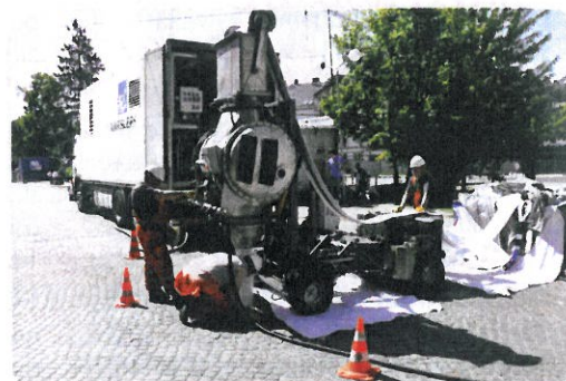
Modernizacja kanalizacji – ul. Kolejowa
