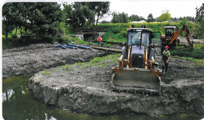
Budowa kanalizacji i wodociągu – ul. Żeromskiego
