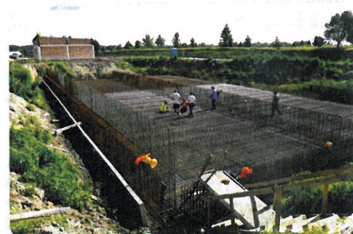
Budowa komór stabilizacji tlenowej - oczyszczalnia ścieków
