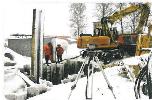
Renowacja kanalizacji - ul. Kołobrzeska
